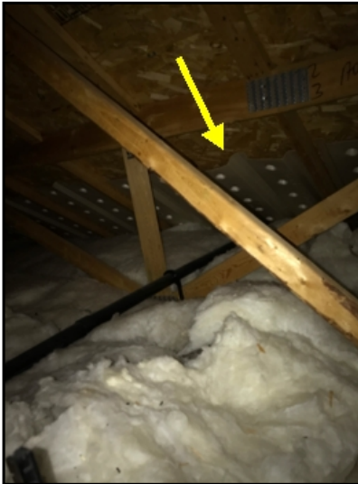
Soffit vent baffles.
